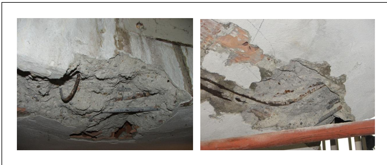
Figura 3 – Assaggio sul cordolo esistente sul contorno del foro
