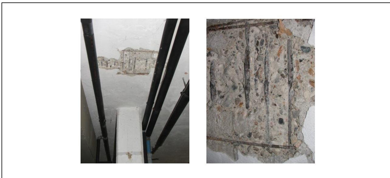
Figura 4 – Assaggio sulla trave principale del solaio
