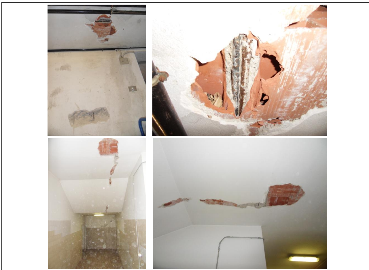
Figura 13 – Assaggi sulle strutture esistenti piano interrato e solaio piano terra
