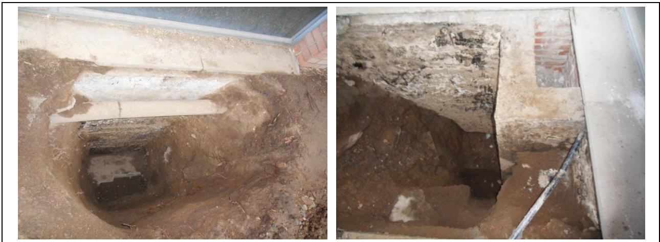
Figura 12 – Strutture di fondazione esistenti in corrispondenza della scala e dell'ascensore esterno
