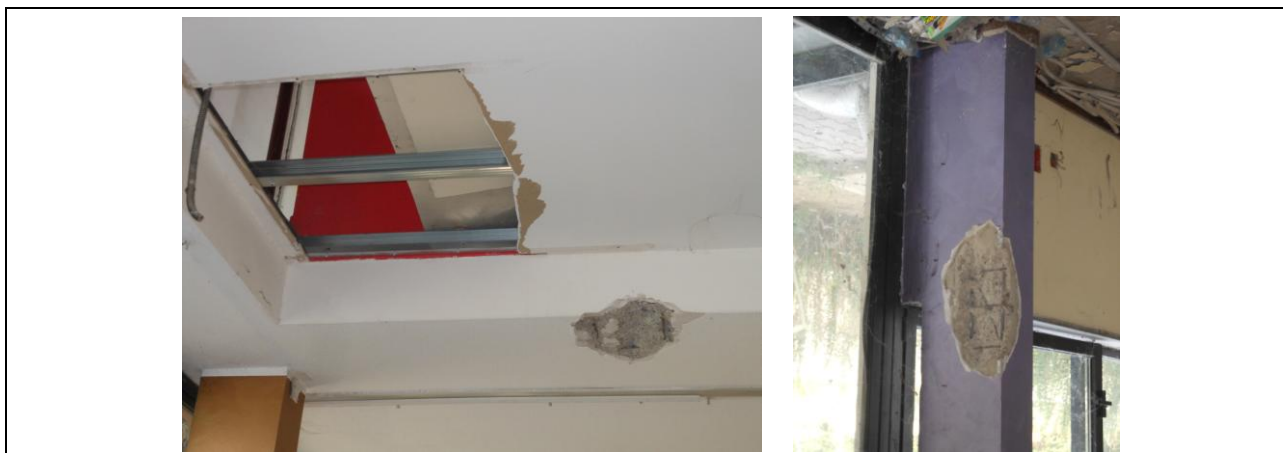
Figura 2 – Assaggi sulle strutture esistenti
