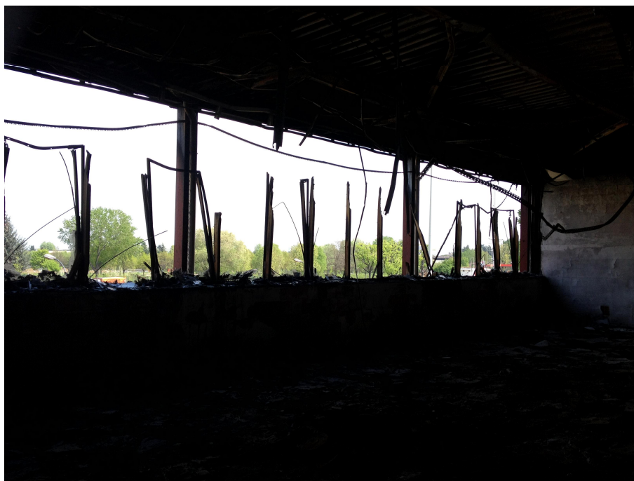
Fig. 6 – materiale instabile su lato oggetto di incendio (parzialmente già rimosso)
