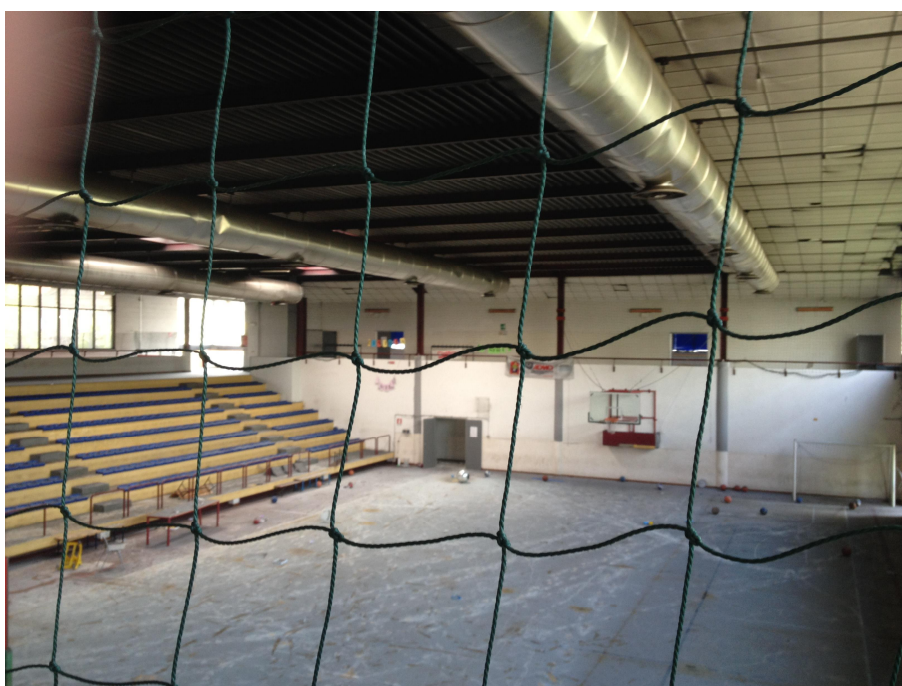
Fig. 5 – Visione di insieme dell'interno
