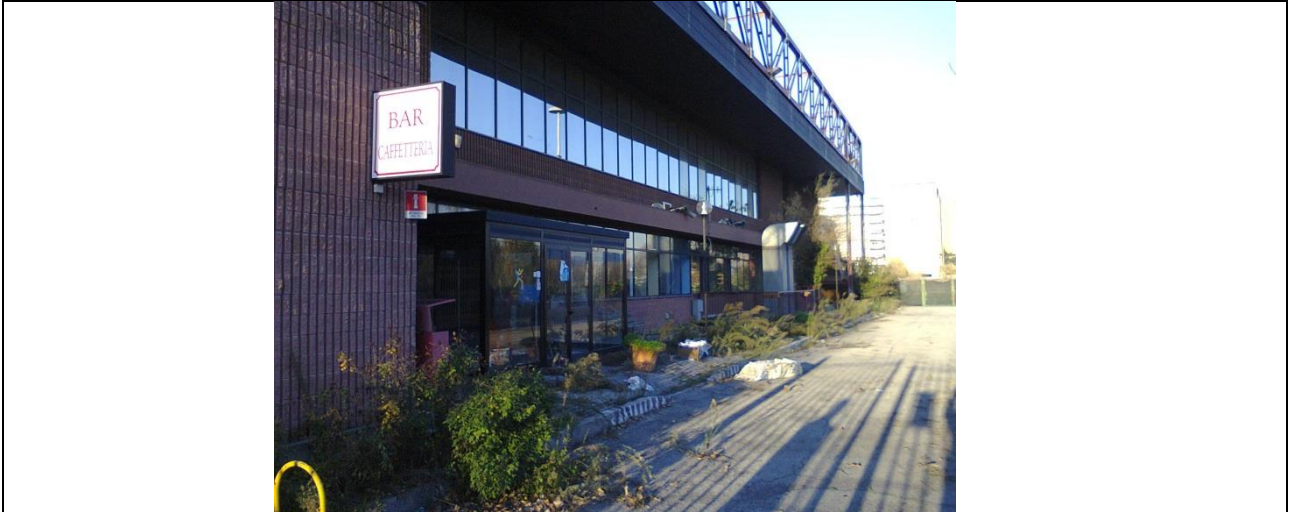
Fotografia 1 – Area ingresso cantiere
