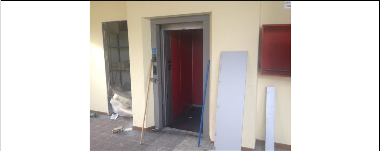
Fotografia 9 - Interno palazzetto – sbarco ascensore
