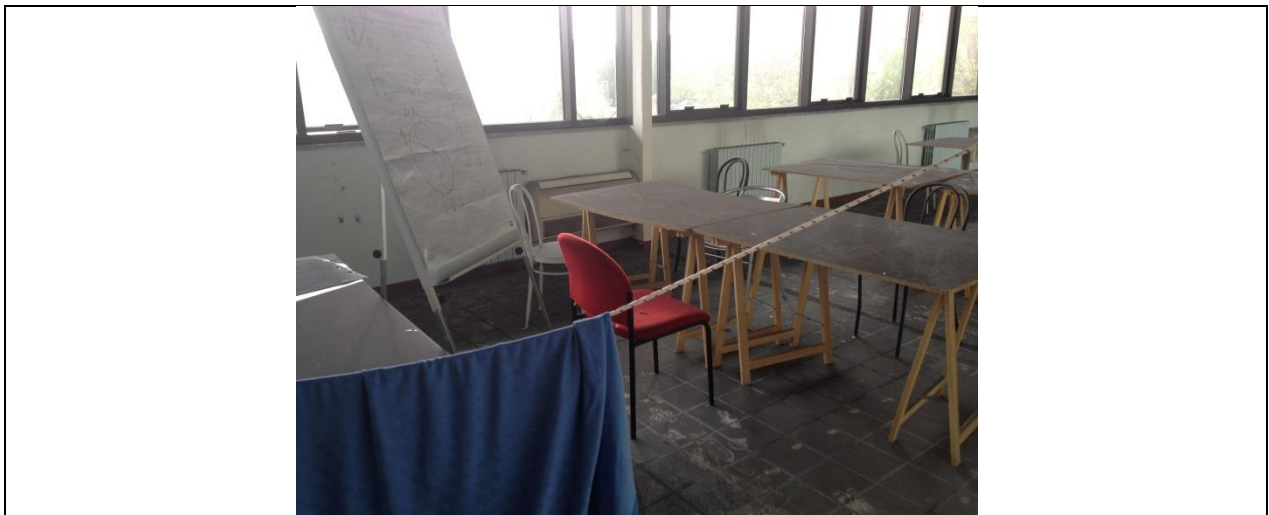
Fotografia 7 – Interno palazzetto – aree da convertire
