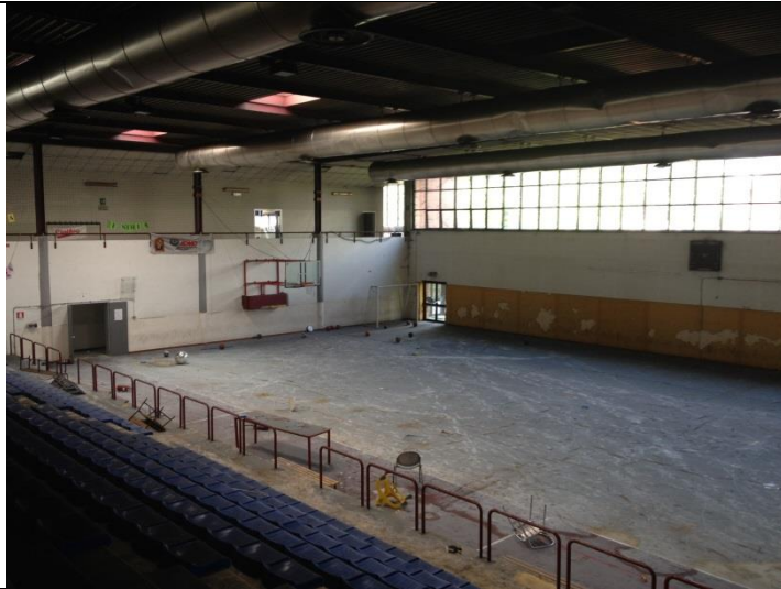
Fotografia 4 – Interno palazzetto – visione d’insieme
