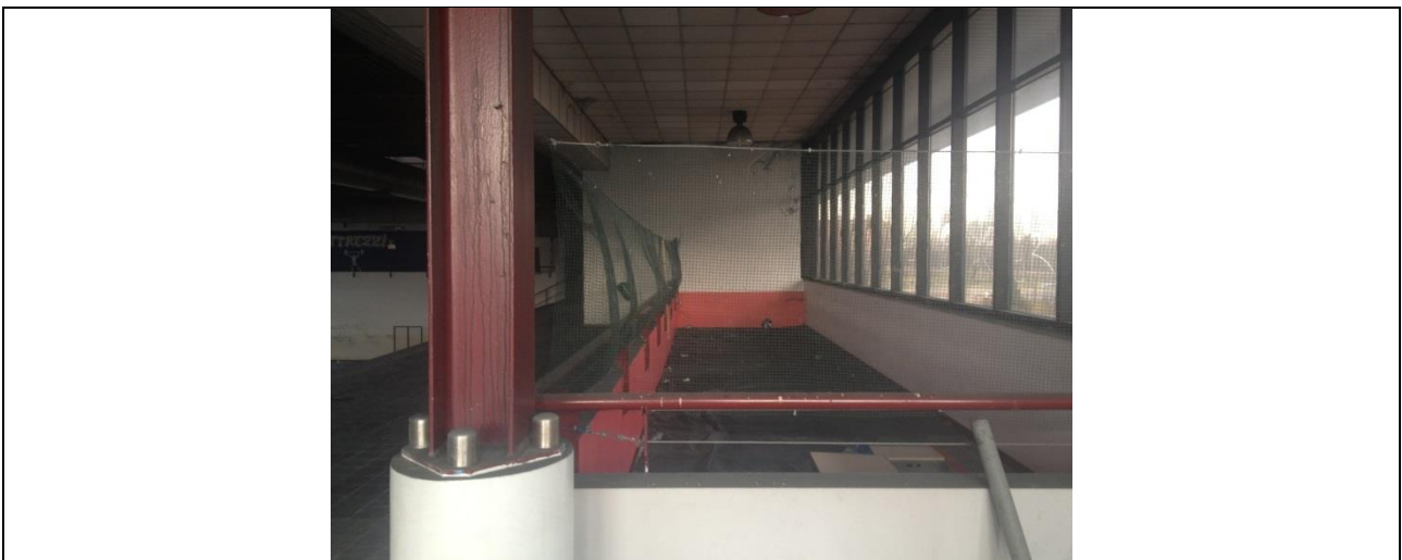
Fotografia 11 – Interno palazzetto – zona di realizzazione nuova soletta
