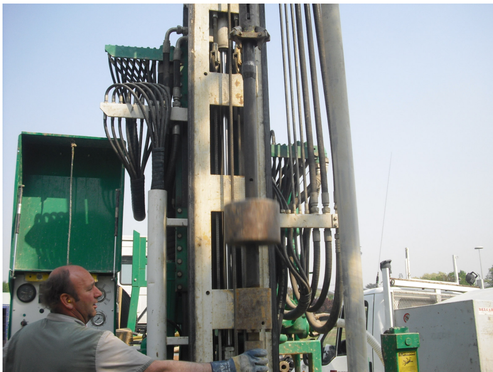
Figura 3 Esecuzione delle prove SPT.
