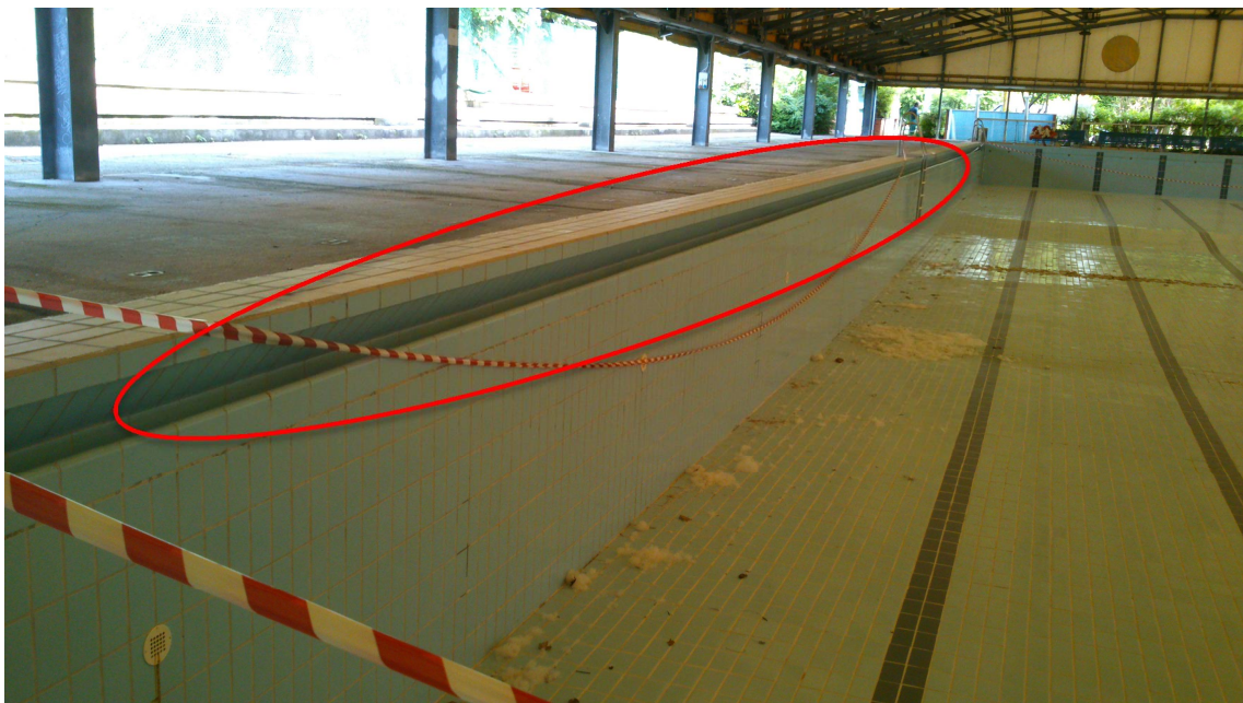
Fig. 4 – Area di lavoro – Dettaglio attuale canalina di scolo
