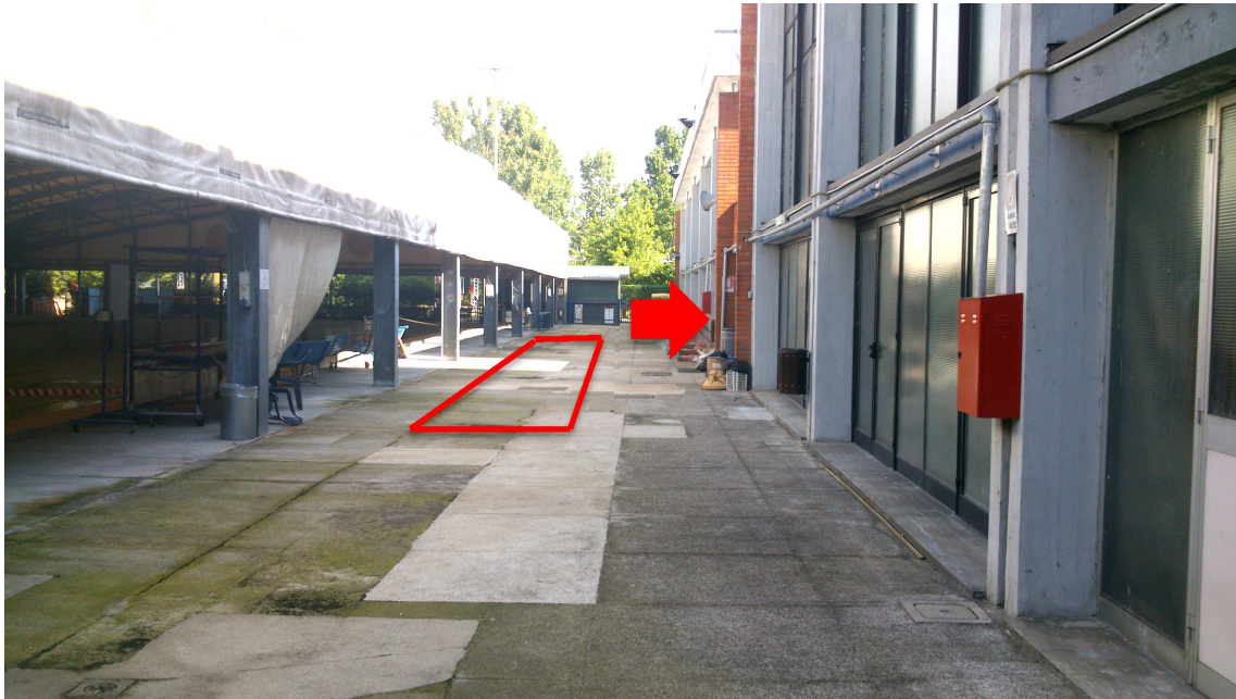
Fig. 3 – Area di lavoro – zona inserimento future vasche di trattamento acque e accesso locale macchine
