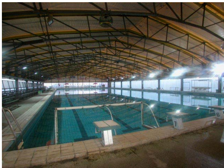
Figura 2: La copertura mobile della vasca 50 metri.
